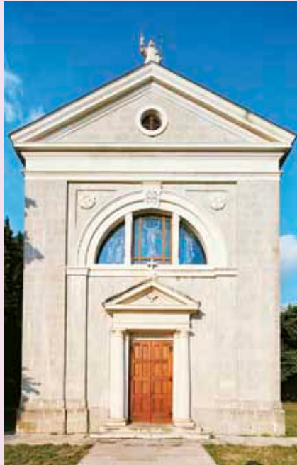
Das im Jahre 1911 erbaute impressive Gebäude der Pfarrkirche des hl. Ante Padovanski dominiert in Gornji Tučepi.
